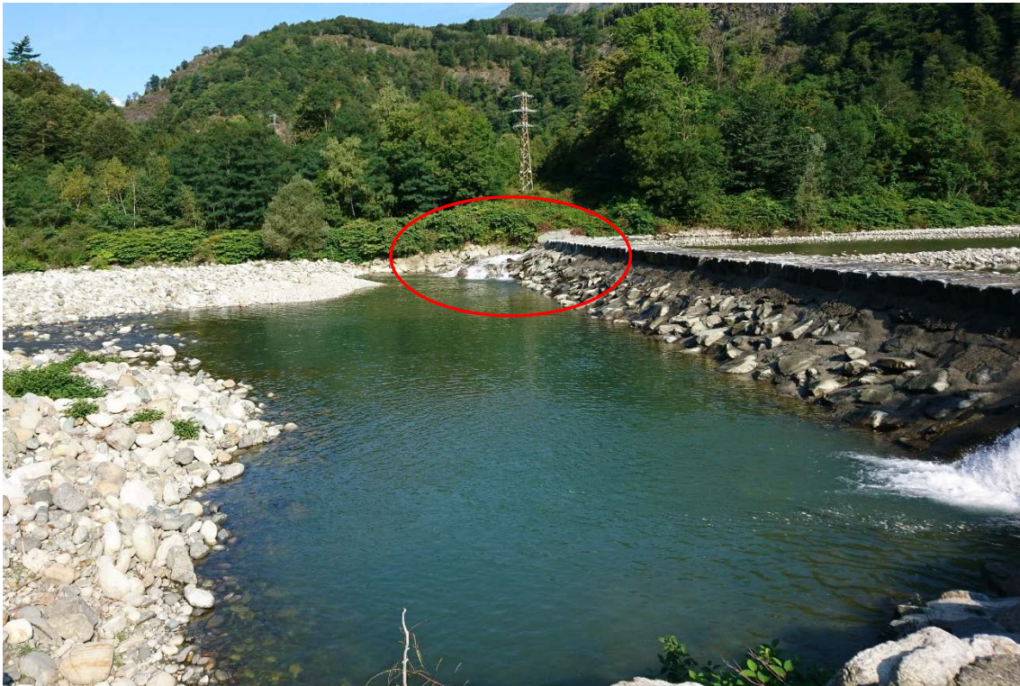
Figura 10: vista dalla traversa da valle, in sponda sinistra, nel cerchio rosso il passaggio per pesci
